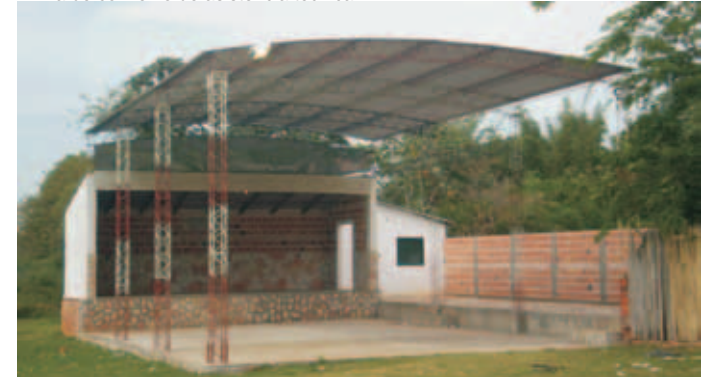
Obra Tinglado multiuso, Club Rincón Guarani
