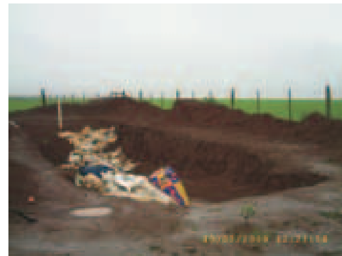
Zanja del relleno sanitario en operación
